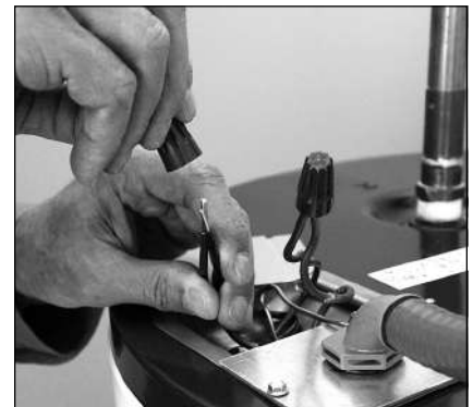
Figure 19 - Connecter les fils électriques.
