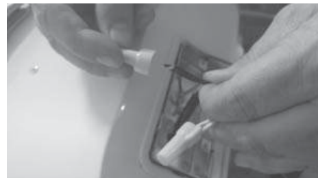
Figure 18 - Connecter les fils électriques.
