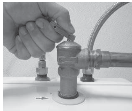
Figure 31 - Soupape de décharge à sécurité thermique
