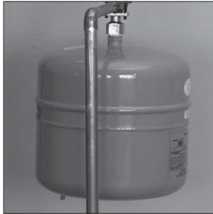
Figure 16 - Le vase d'expansion doit être pressurisé à l'air à une pression égale à celle de l'arrivée d'eau du domicile.
