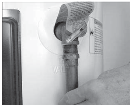
Figure 12 - Le tuyau d'écoulement de la soupape DST doit être installé correctement et se déverser dans un écoulement approprié.
