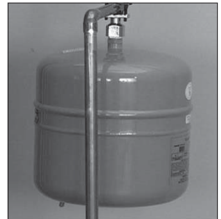
Figure 5 - Le vase d'expansion protège la plomberie du domicile contre les pointes de pression.
