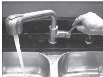
Figure 9 - Laisser couler l'eau chaude jusqu'à ce qu'elle soit fraîche.
